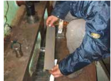
2. Preparación encofrado exterior
